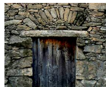
Puerta con dintel
